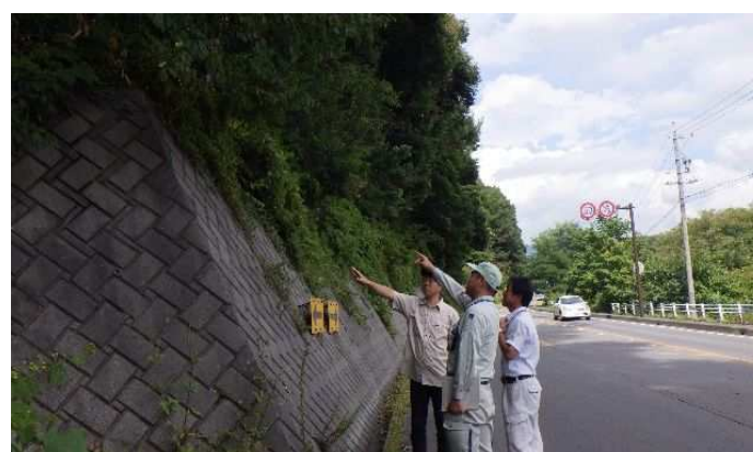
維持系県事業現場視察 南大塩地区 支障木対策（9月3日）
