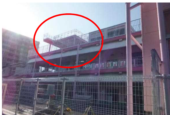
図 15 屋上への避難場所を増築した事例
