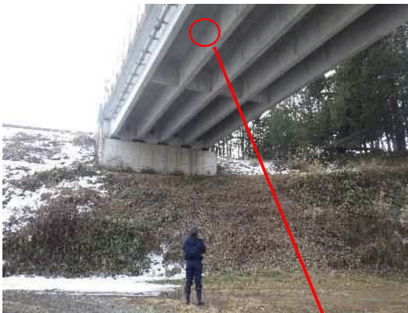
令和5年度点検 上場沢大橋 豊平
