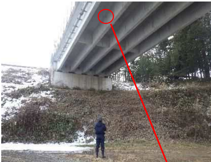
令和5年度点検 上場沢大橋 豊平
