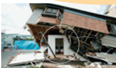
※倒壊実験写真
