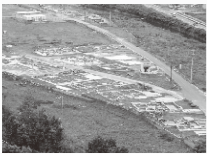
基礎だけ残った住宅地 (志津川中学校より望む)
