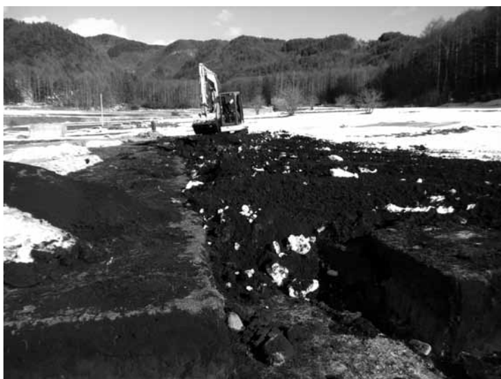
3 埋め戻し作業
