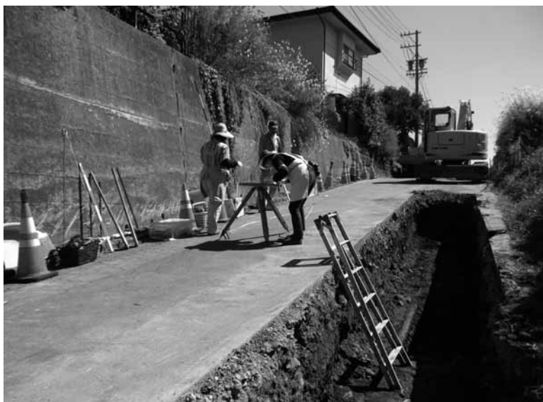
11 作業風景③(西より)
