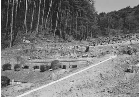
図版 18 調査前全景 1
