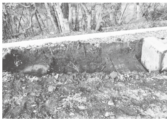
図版 33 基礎北辺 (南から)
