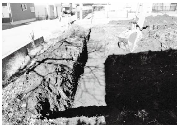
図版 70 基礎西辺 (南東から)
