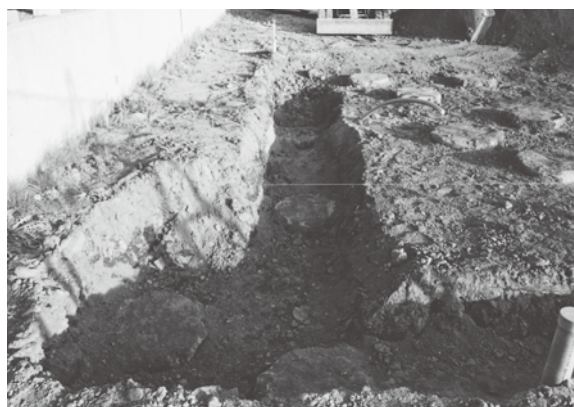
図版 63 掘削状況 2(北西から)
