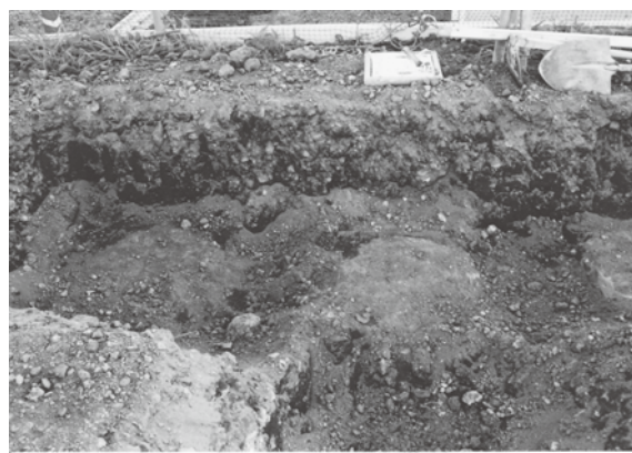
図版 62 掘削状況 1(北東から)
