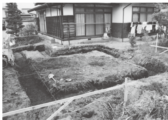
図版 50 調査後全景
