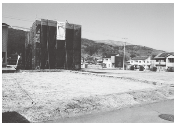
図版 16 調査前全景
