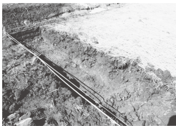
図版 17 1区掘削状況
