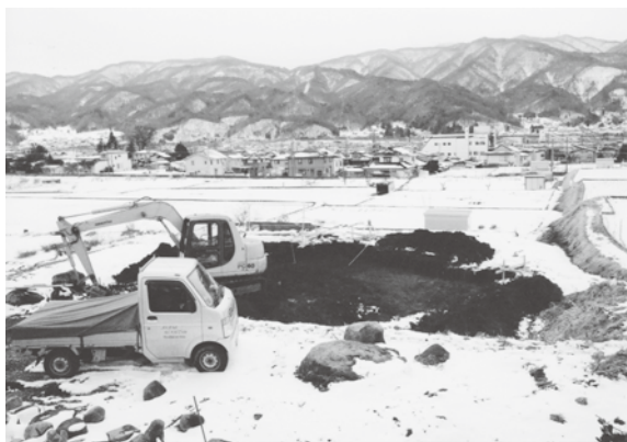
工事に立ち会ったところ、南コーナーの一部を除き、地山に掘削が及ぶこととなった。事業者の承諾を得て調査を行った結果、北側断面に柱穴状の小さな落ち込み、建築範囲の中ほどにローマウンドとみられる落ち込みを確認した。北側および西側の断面図を作成し、調査を終了した。
