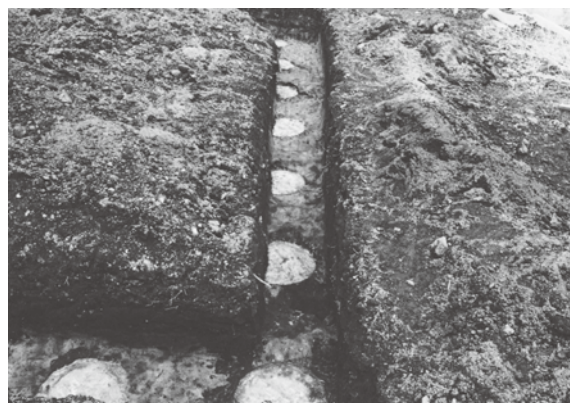
図版 86 掘削状況 2
