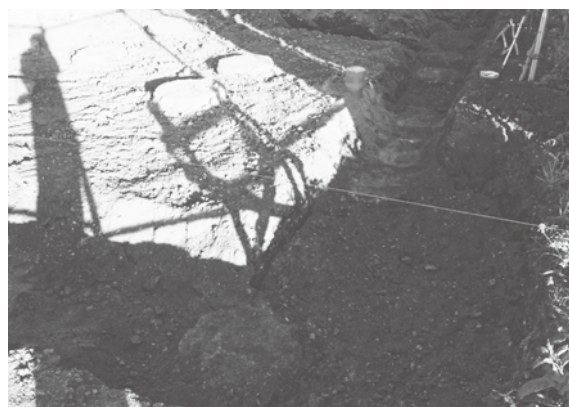
図版 64 掘削状況 3(北西から)
