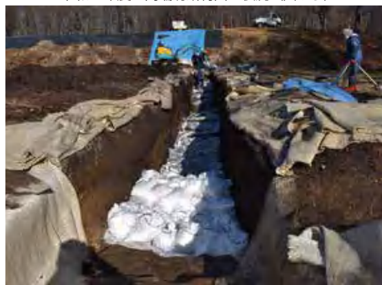
令和3年度 調査区埋戻状況（南から）
