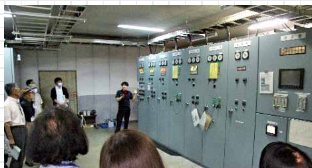
▲ 横内送水場の中を見学
