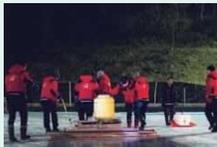
大会前には「雑巾がけ」を行い、リンクを滑らかにする。写真は、タンクから出る水を浸した毛布で雑巾がけ作業をする様子。
