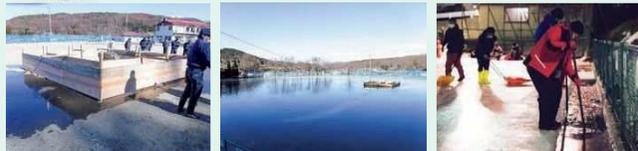
校庭中央に「水取り入れ口」、周囲に「防風ネット」を設置する。水取り入れ口だけだと波が立ち、水面が凍らないため、周りに「波消し板」を設置する(写真左)。水を張り、氷が張ったらリンク中央が盛り上がるのを防ぐ緩衝帯を作る(写真右)。
