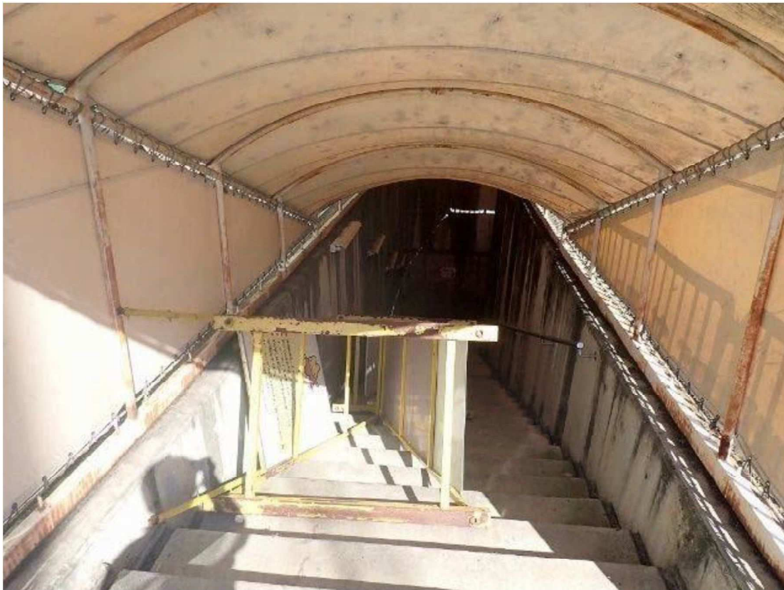
屋根フレームの鉄に錆
