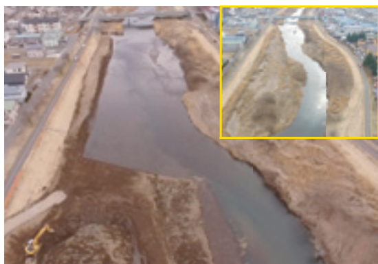
▲堀削工事後の様子。右上は工事前。
