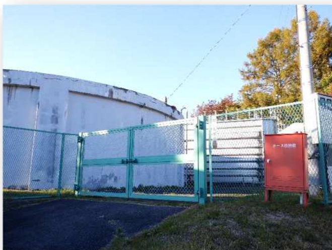
梨の木配水池
