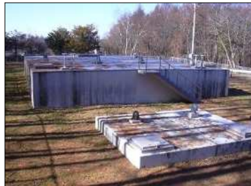
堀配水池 (RC構造)
