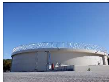
埴原田配水池
