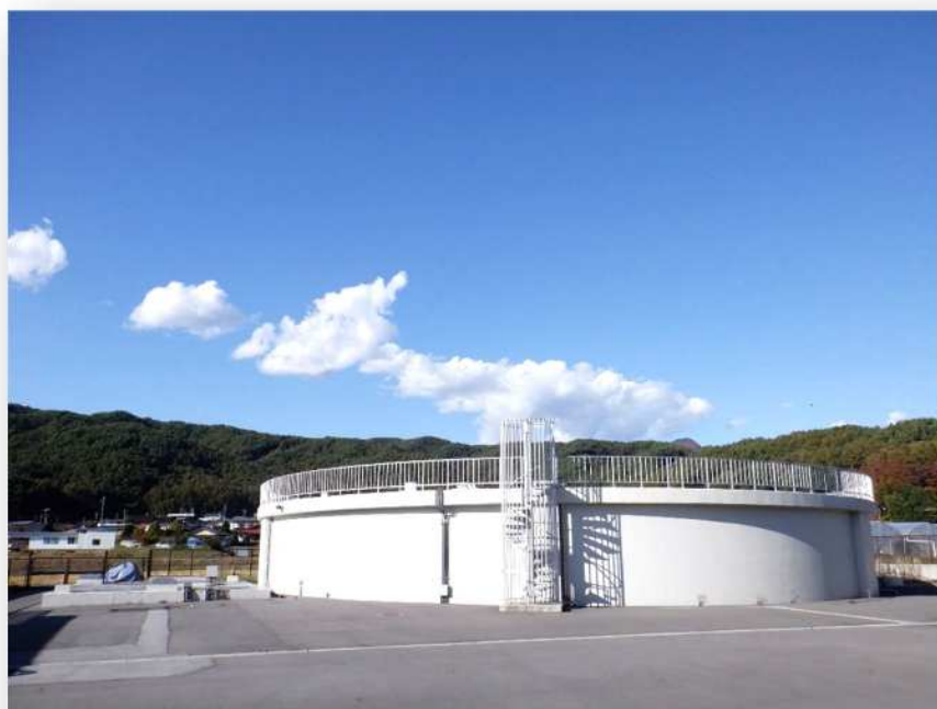
北大塩中区配水池
