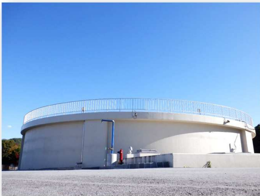
埴原田配水池
