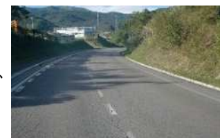
舗装修繕予定のエコライン
