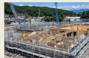
永明小中学校の建設や周辺整備
