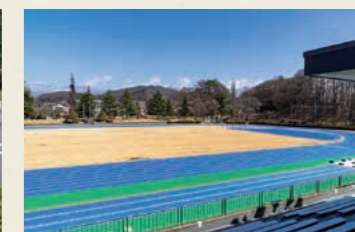
陸上競技場の更新改修
