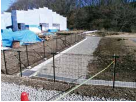
廃道分は既存の道路へ付け替えされる。(砂利部分)
