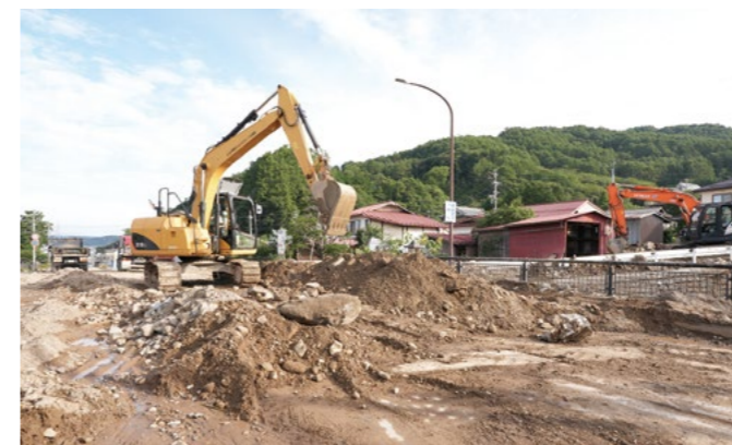
↑重機による土砂除去作業
