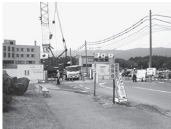
正面玄関へ向かう道から撮影
