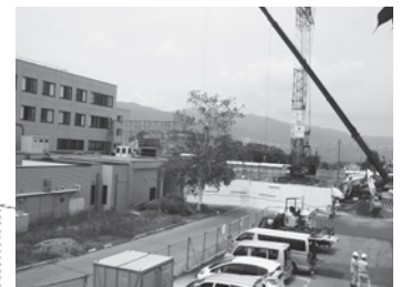
病院東側から撮影
