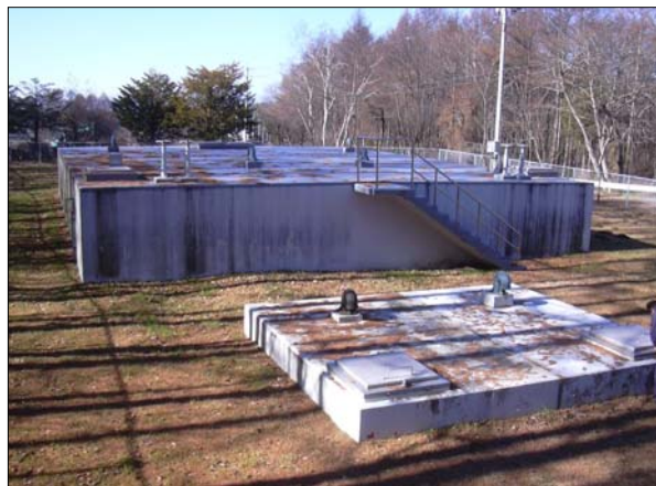
堀配水池（RC構造）
