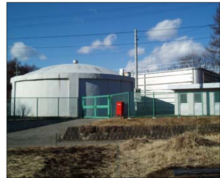
梨の木配水池
