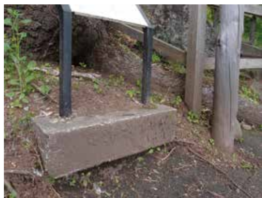
写真 4-18 説明板（基礎の露出）
