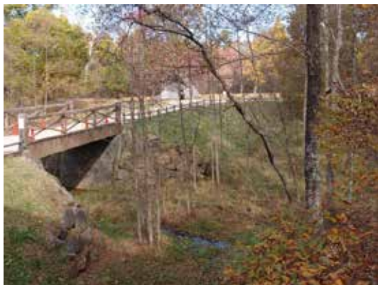
写真 4-11 与助尾根地区へ続く木橋（改修前）
