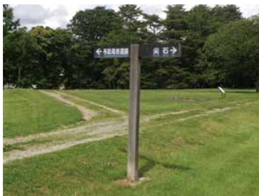
写真 4-15 尖石地区 誘導標識（支柱下部の劣化）
