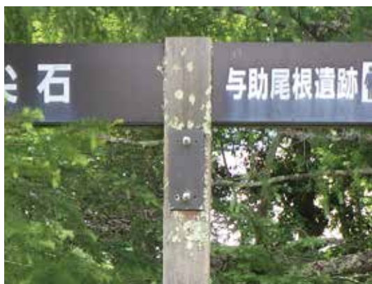
写真 4-17 誘導標識（支柱へのコケ付着）
