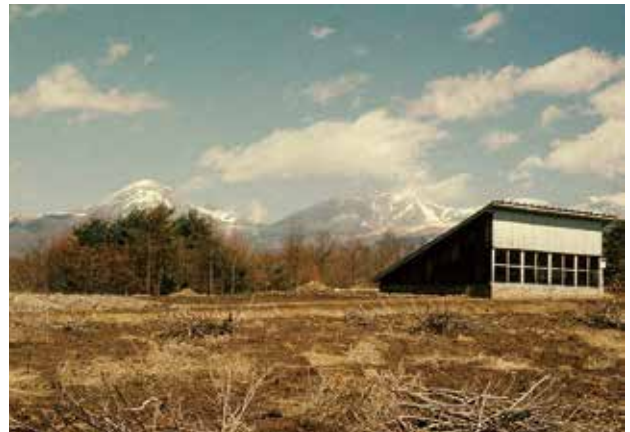
写真 3-14 33 号住居址の覆屋
