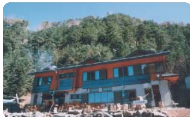
太陽光・風力ハイブリッドシステムにより合併処理浄化槽を稼働させている夏沢鉱泉
