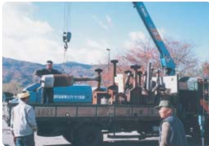
小型焼却炉の撤去
