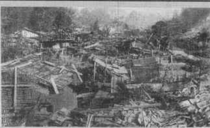
「濃尾大震災写真帖」中の高富町破壊状況
