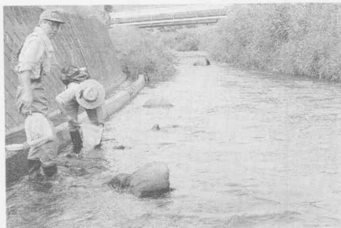
図 10 茅野市横河川鋳物師屋上橋
