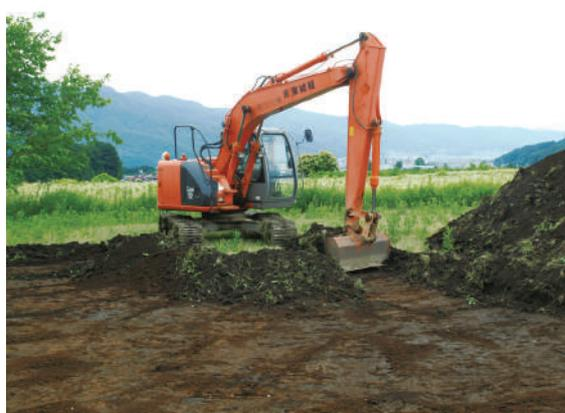
図版1 重機による表土剥ぎ作業
