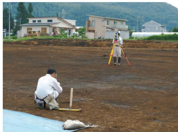
図版 5 測量会社による杭打ち作業
