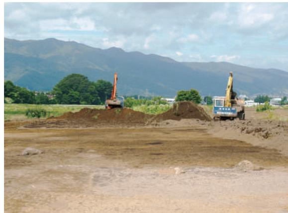
図版 3 重機による表土剥ぎ作業
