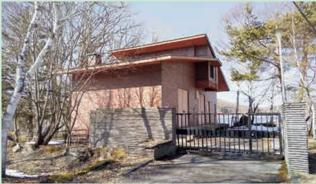
南中継ポンプ場
