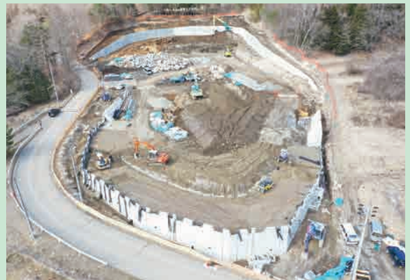
諏訪南リサイクルセンター造成状況
