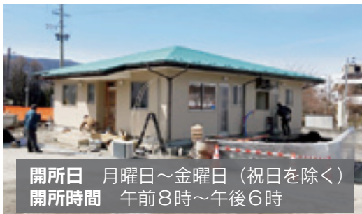
▲開所に向け工事が進むおやすみ館
