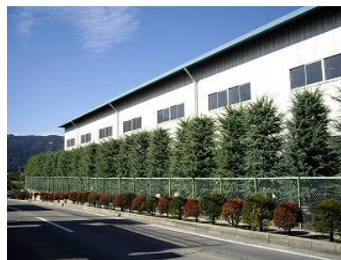
敷地周りの緑が豊かな工場
